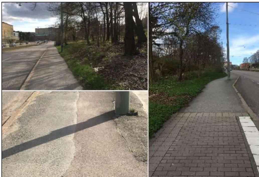
Figur 4 Befintlig gångbana utmed Guldhedsgatans västra sida
